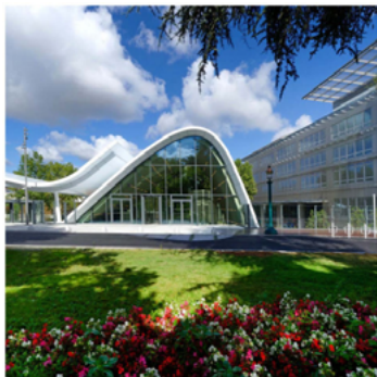
CRÉDIT AGRICOLE - CHANTIER ÉOLE Montrouge, France
